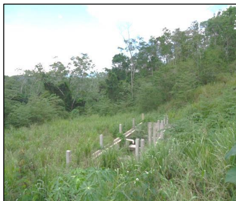
F34: Ubicación del Tanque de Concreto
