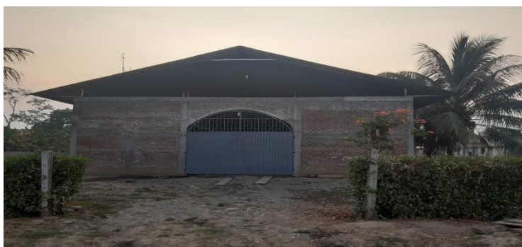
F32: Equipamiento Otros Usos Selva de Oro: Iglesia Evangélica.
