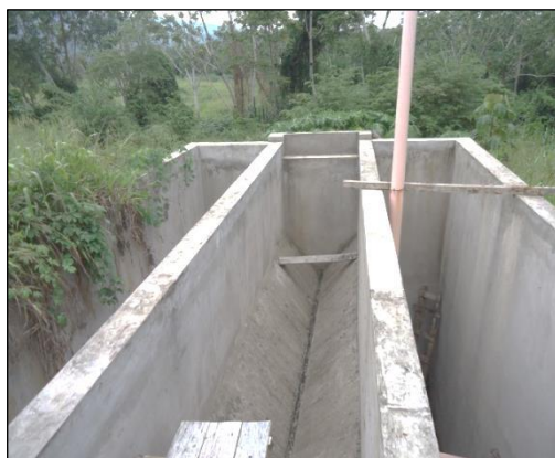
F33: Tanque de Concreto
